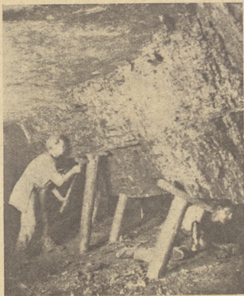
(a) Ściana węglowa. Jeden człowiek rąbie węgiel, drugi umocowuje podpory.
