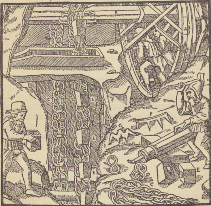
Fig. 45. — Wydobywanie wody zapomocą kubłów, zawieszonych na łańcuchu, poruszonym przez kołowrót. Na pierwszym planie widzimy jednego człowieka, niosącego świeży kubel i drugiego, który wbija skobel (F lub G) w beczkę (B).
