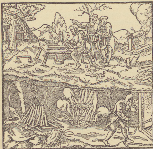
Fig. 56. — Rozbijanie skał zapomocą kolejnego działania ognia i wody. Robotnik u góry nakłada wióry na każdą wiązkę chróstu. U dołu robotnik po zapaleniu ognia ucieka przed dymem. (Rysunek z książki Agricoli).
