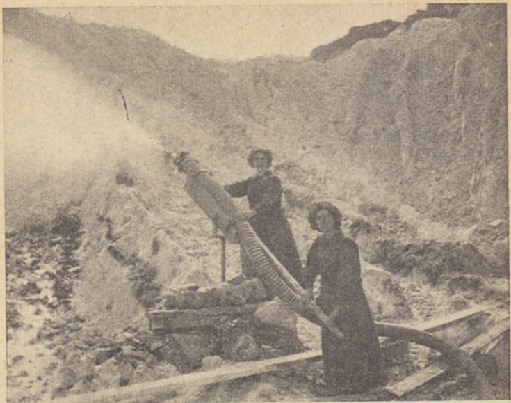
(a) Zmywanie gliny w kopalni.
