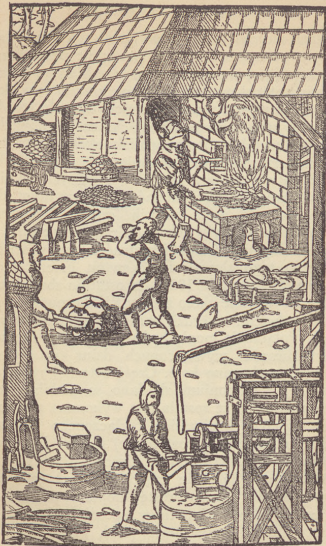
Fig. 14. — Z książki De Re Metallica Agricoli . A — ognisko; B — stos; C — wyjście szlaki; D — masa żelazna; E — młotki drewniane; F — młot; G — kowadło. Zauważmy, że człowiek przy ognisku ma zasłonę na twarzy.
