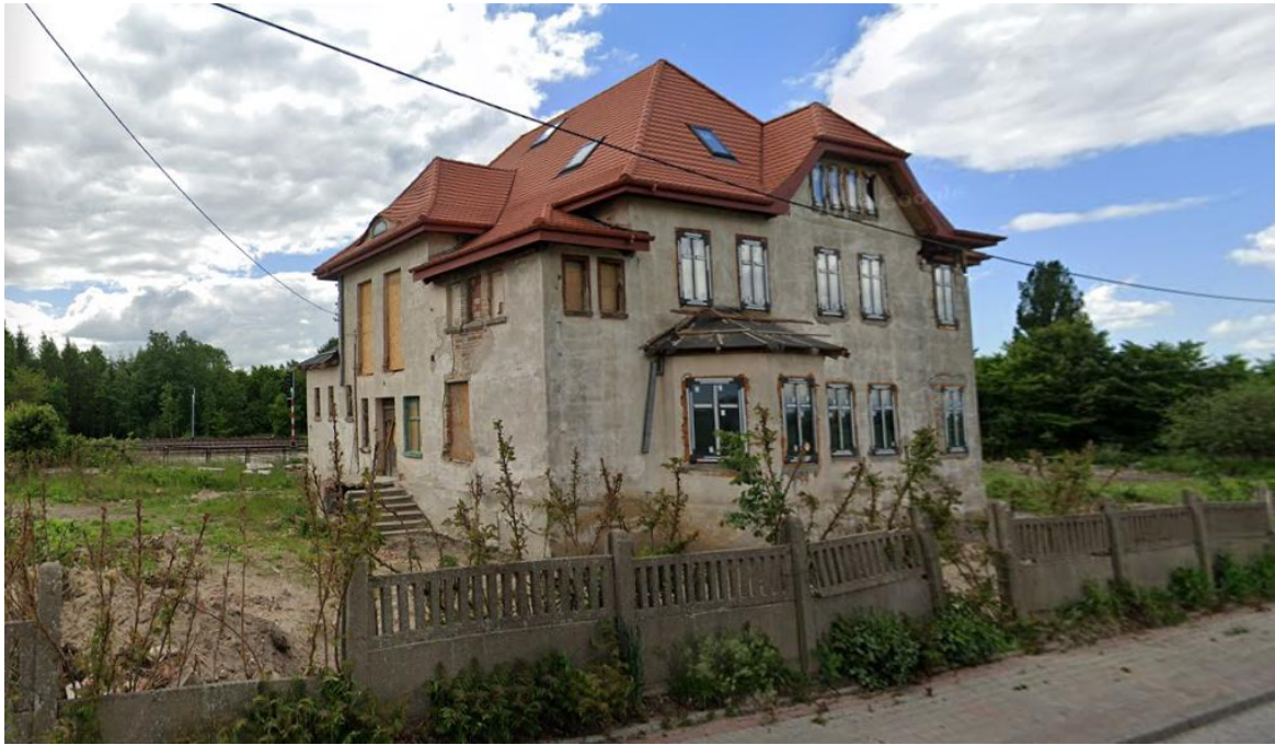
Jeden z budynków stacji kolejowej Gardeja.
