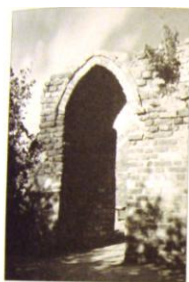
Ryc. 4. Grudziądz, gm. loco, stanowisko 1. Zrekonstruowana pod koniec XIX w. brama na dziedziniec zamkowy (stan z lat 30. XX w.) (fot. ze zbiorów M. Szajerk)
