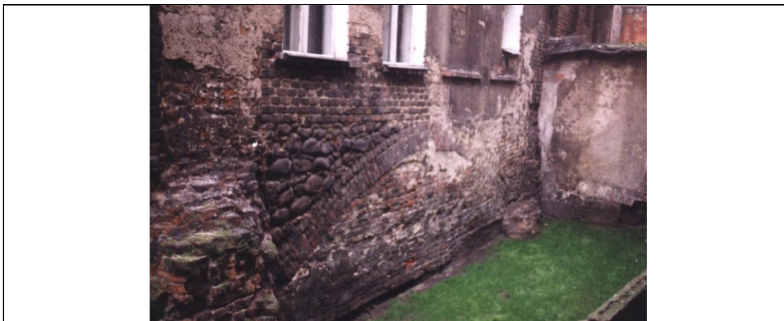
Zdjęcie Bramy św. Chrystiana z ok., 2002 r. Fot. M. Szajerka. Na uwagę zasługuje wypełnienie kamieniami części muru nad łukiem, w wątku cyklopowym. W prostopadłym murze widoczny łuk furty do szyi bramnej.
