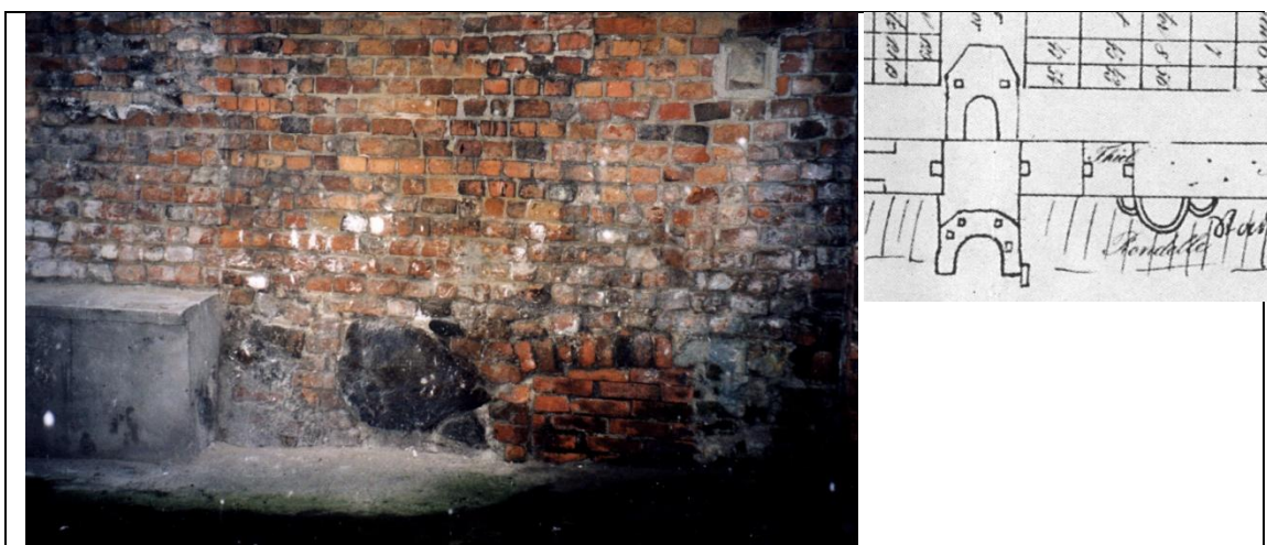
Łuk furty bocznej przy dawnym prześwicie bramy, za murem szyi.
