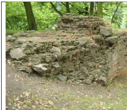
Fragment muru w części południowo-wschodniej. Fot. Wojciech Orzepowski. Stan w 2008 r.
