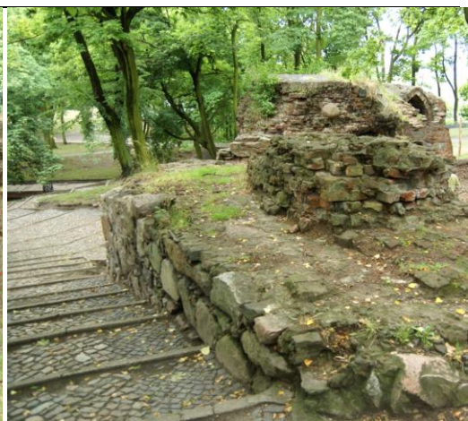
Fragment muru w części południowo-wschodniej. Fot. Wojciech Orzepowski. Stan w 2008 r.
