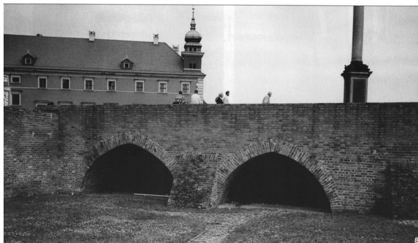
8.9. Warszawa – most przedbramia Bramy Krakowskiej (8) i mur arkadowy o identycznej konstrukcji, jak w mostach grudziądzkich (9) (zdjęcia: 3-7 – Mieczysław Kucharski, 8,9 – Marek Szajerka)
