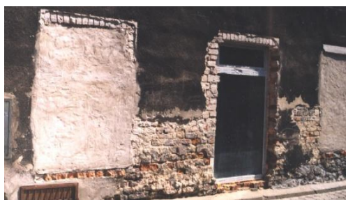
Ściana kamienicy przy ul. Murowej 3. Stan w 2002 r. Fot. M. Szajerka.
