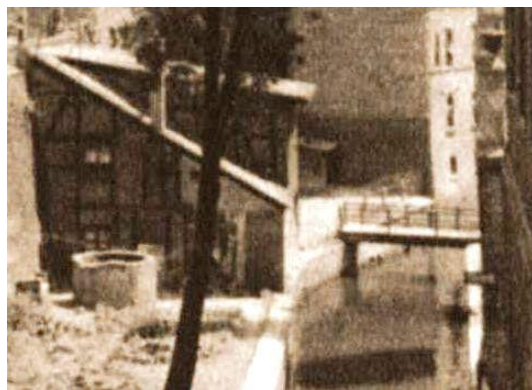
Studnia od pompy ssąco-tłoczącej
