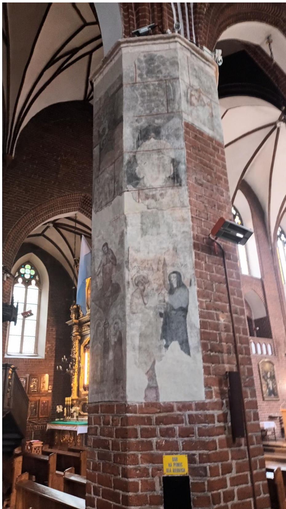
Filar w nawie południowej. Stan w 2024 r. Fot. M. Szajerka.
