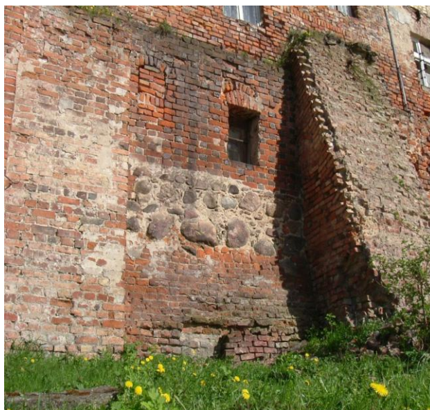
Spichrz 37. Zaprzeczenie niemieckiej datacji wiązań. Fot, M. Szajerka
