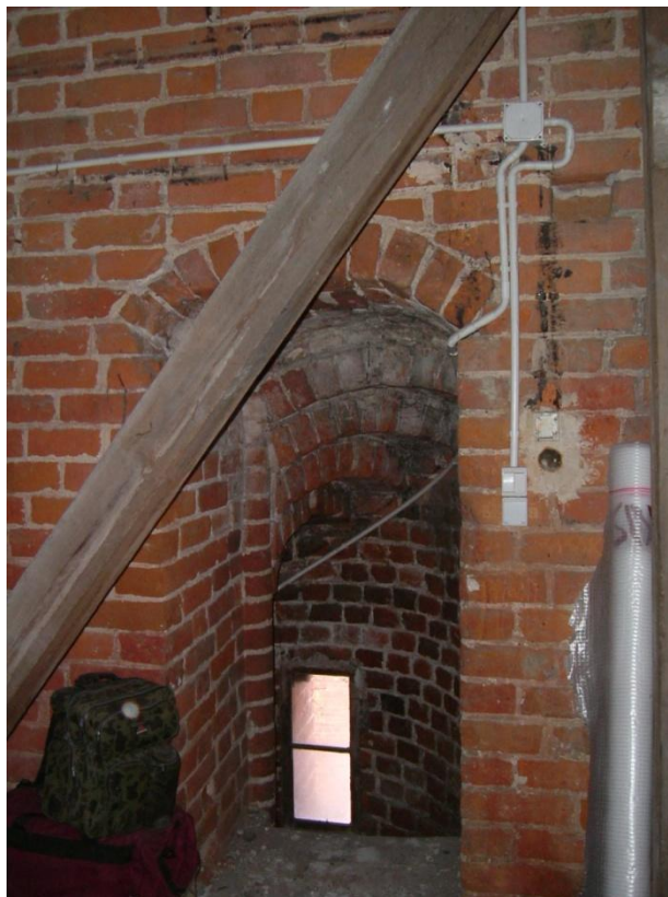
Zdjęcie zachodniej klatki schodowej, wykonane 16.04.2008 r. Fot. M. Szajerka.
