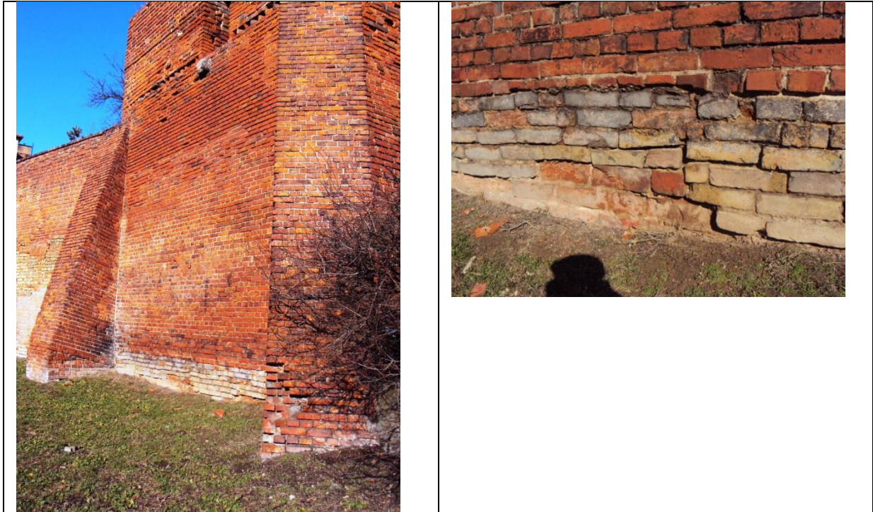
Warstwy w przyziemiu, wykonane z cegieł romańskich, niedopalek, z zastosowaniem wiązania wózówkowego.
