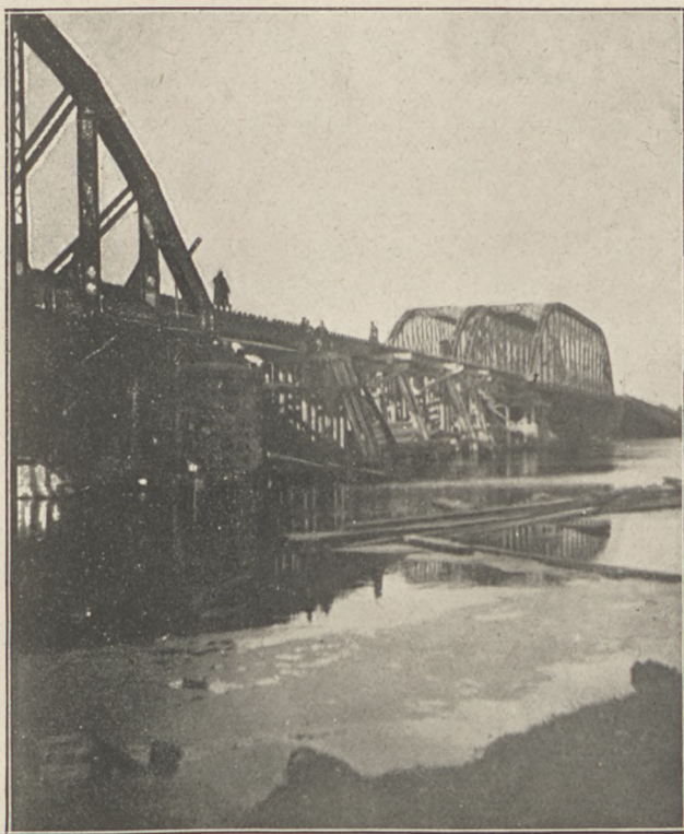
Odbudowa mostu na Berezynie, pod Borysowem.
