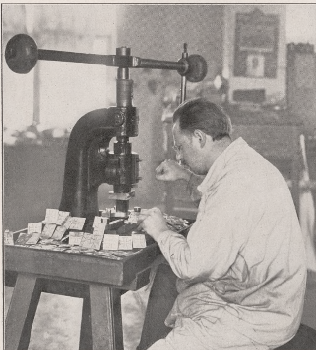
Von der Herstellung des Eisernen Kreuzes: Das Aufpressen von Silberdraht auf den silbernen Rand.
