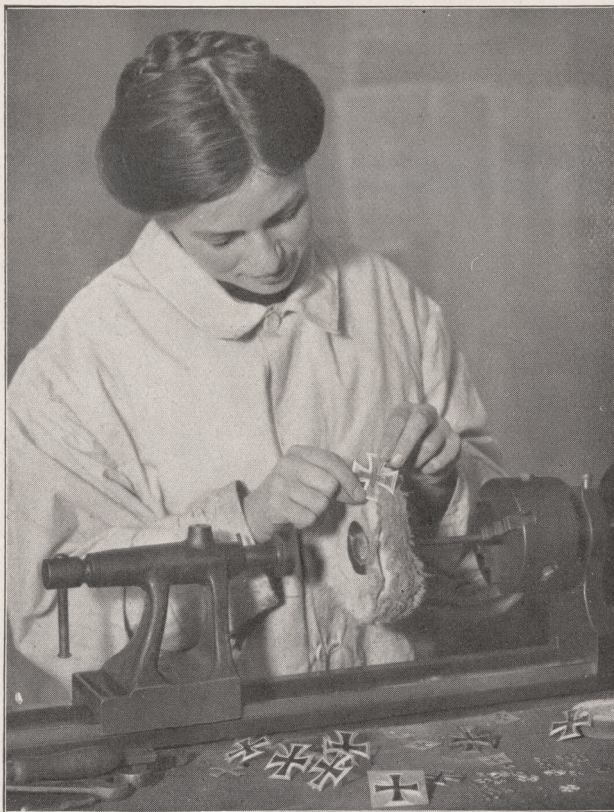
Von der Herstellung des Eisernen Kreuzes: Das Hochpolieren der fertigen Kreuze.
