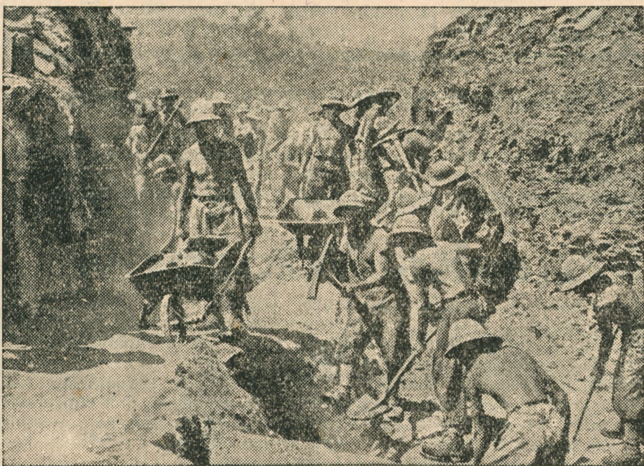
Budowa dróg w Abisynji.
