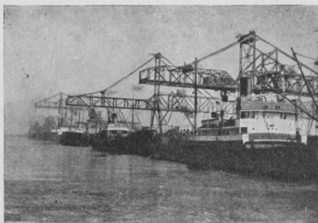
Nabrzeże szwedzkie: dźwigi mostowe dla przeładunku towarów masowych
