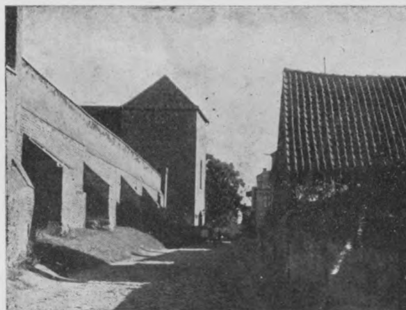
Chełmno: Fragment murów od strony wewnętrznej przy „Bramce“
