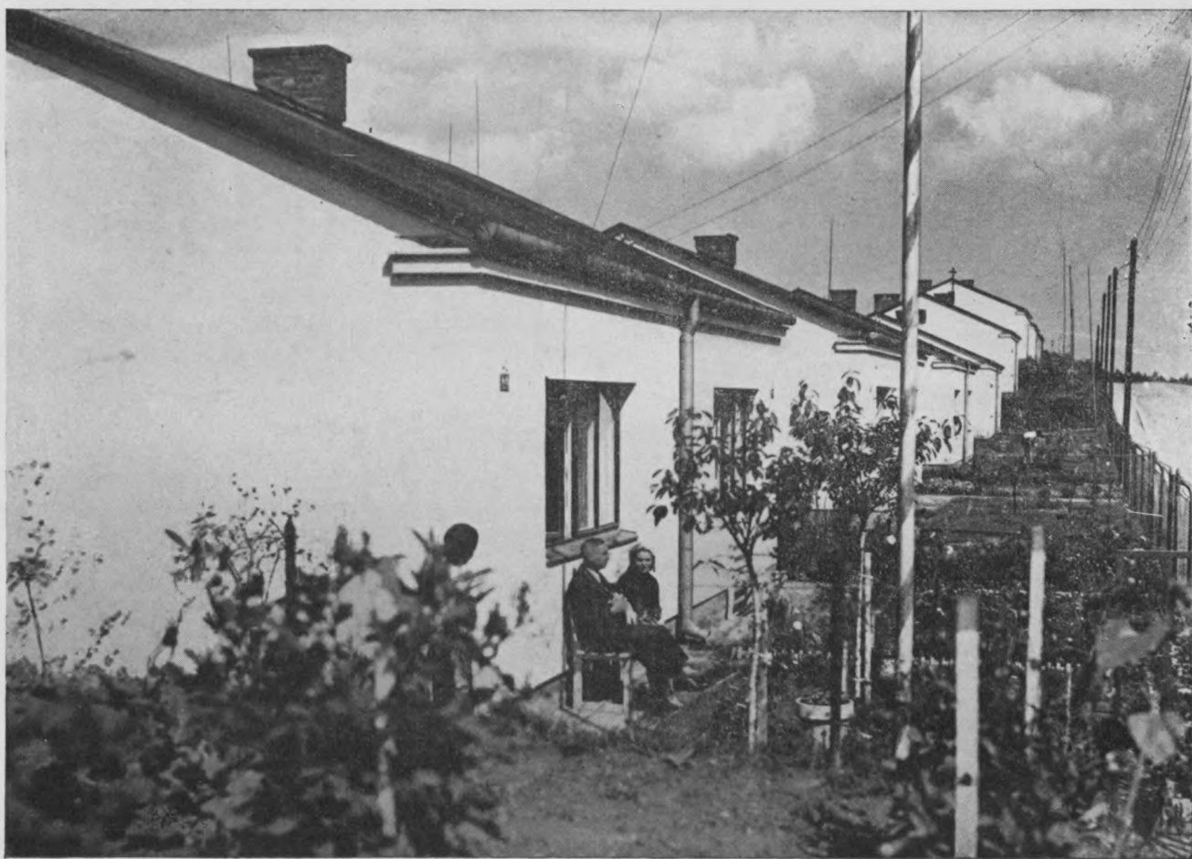
Witomino, osiedle robotnicze (budowa z 1937 r.)
