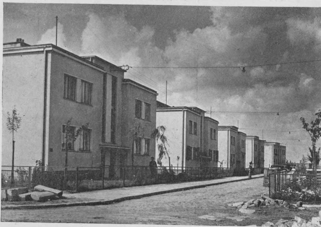
Redłowo: Fragment ul. Wojewódzkiej (budowa w 1937 r.).
