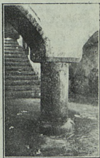
Słup granitowy w podziemiach ratusza.
