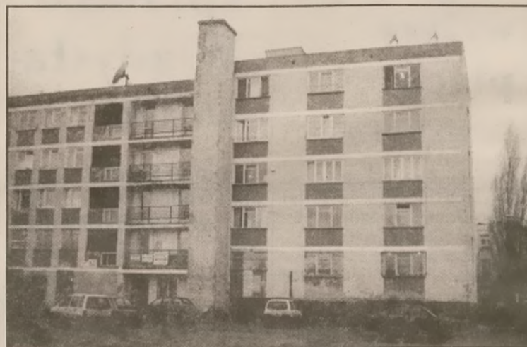
Zbiornice anteny satelitarne w Barcinie umieszczone są na budynku, w którym mieści się siedziba Spółdzielni Mieszkaniowej "Kujawy" fot. Kamila Mróz
